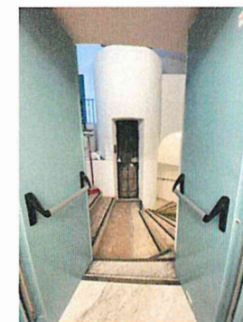
3. Corpo scala e sbarco ascensore
