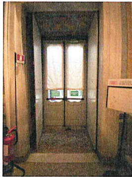
5. Uscita di emergenza lato est
