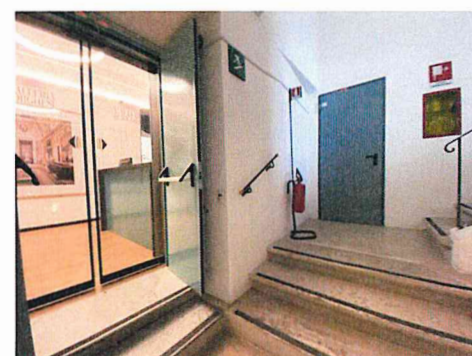
2. Sbarco su scale/ingresso
