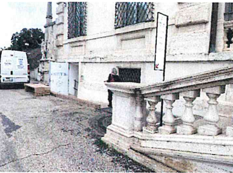
1. Ingresso Piano Seminterrato
